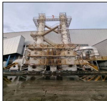
ภาพที่ 2.2 ระบบบำบัดมลพิษทางอากาศ (ระบบดักฝุ่นเปียก Wet Scrubber)
