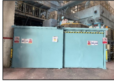
ภาพที่ 2.9 ห้องครอบเสียงเครื่องฉีดขึ้นงานอัตโนมัติ และห้องครอบเสียงกระบะก้น
