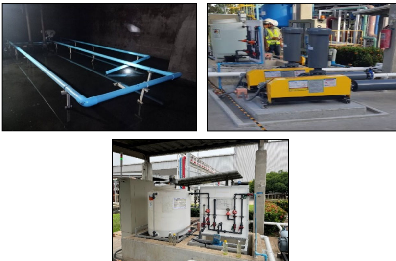
ภาพที่ 2.13 ระบบบำบัดน้ำเสียในส่วนของการเติมอากาศ
