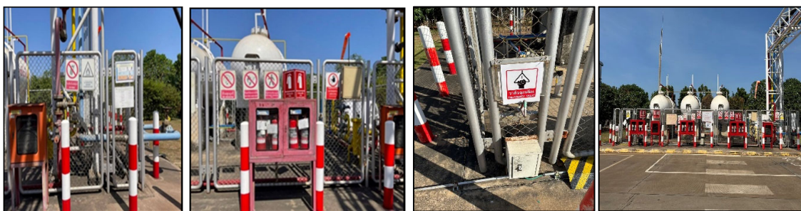
ภาพที่ 2.47 บ้ายเตือนอันตราย วิธีปฏิบัติเพื่อความปลอดภัย ตลอดแนวท่อส่งก๊าซ LPG
